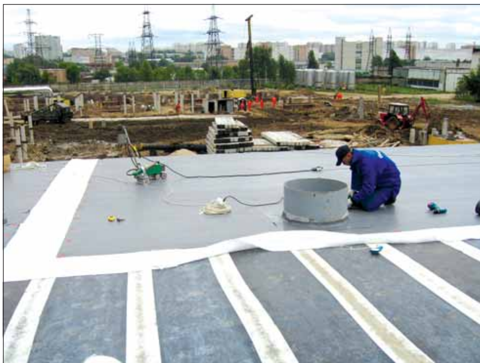
Монтаж кровли «Lastingroof» (по варианту крепления свариваемой мембраны непосредственно к пенорезольному утеплителю)
