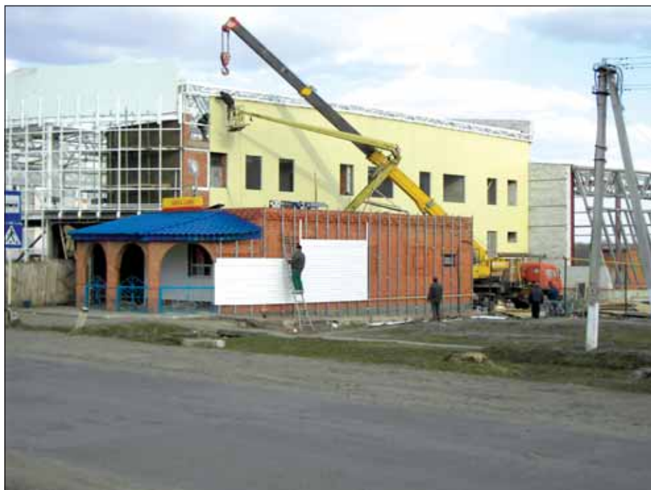
Строительство Физкультурно-оздоровительного комплекса в селе Шихозаны (республика Чувашия)
