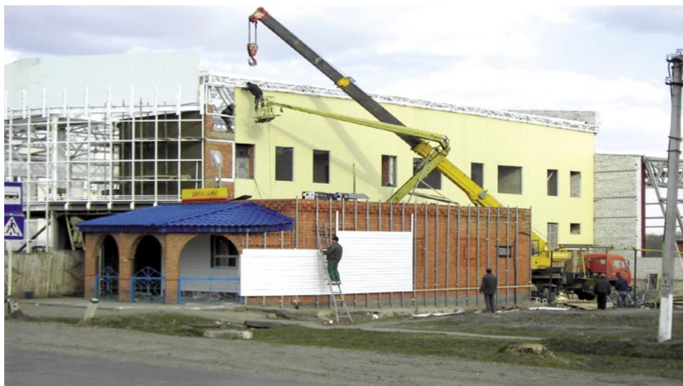
Строительство Физкультурно-оздоровительного комплекса в селе Шихозаны Республики Чувашия
