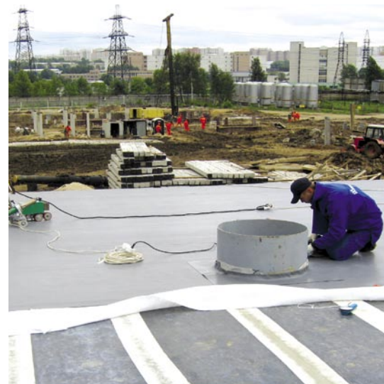
Монтаж кровли «Lastingroof» (по варианту крепления свариваемой мембраны непосредственно к пенорезольному утеплителю)
